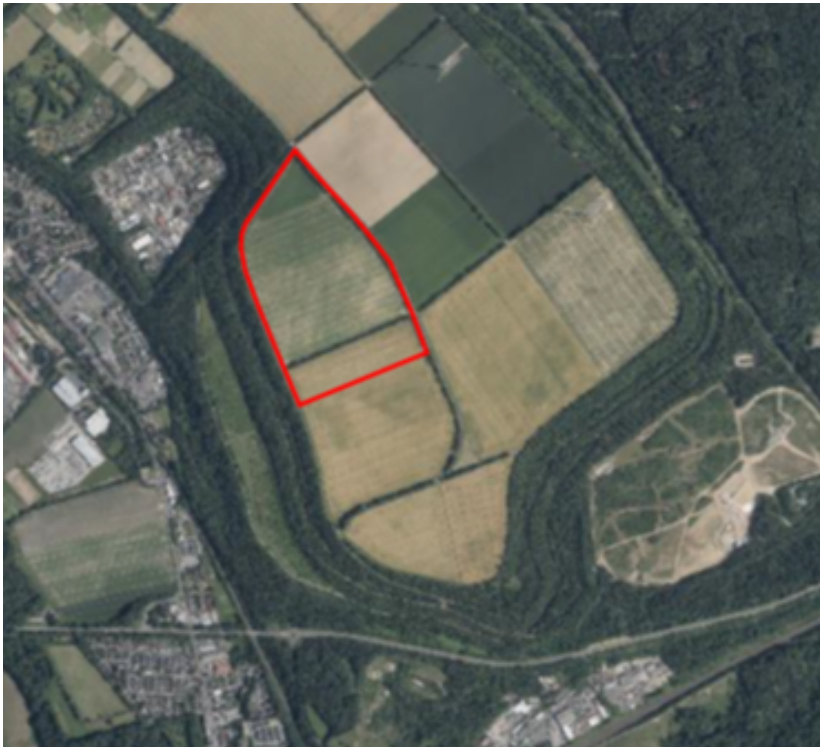
Abb. 1 Fischbachhöhe im Luftbild mit Vorhabenfläche (rot)
